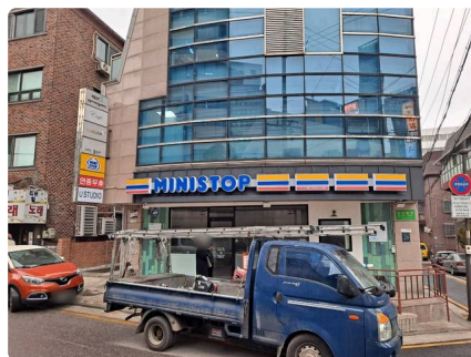
미니ストップ 가맹점 전면 간판 최근 시공
